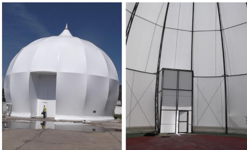
Slika 13.1: Spoljašnji izgled visokonaponske laboratorije (levo), kao i unutrašnji izgled (desno)
