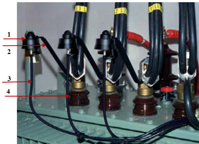
Slika 11.16: Način fiksiranja odvodnika na transformatorski sud
