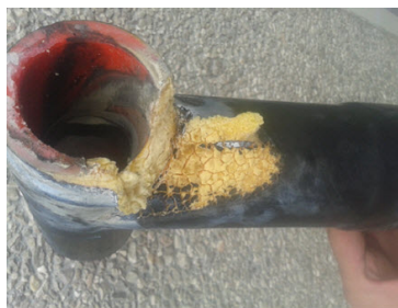
Slika 5.9: Probijena kablovska završnica
