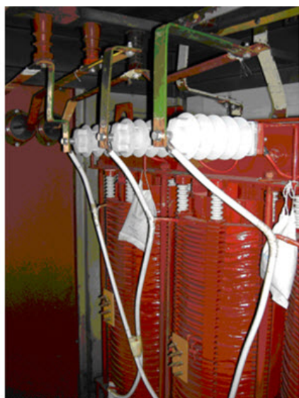
Slika B.11: 1 Slike uljnog i suvog transformatora sa postavljenim odvodnicima prenapona sa silikonskim kućistima direktno na konstrukciji
