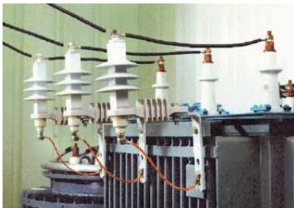
Slika K.10: Primer instalacije odvodnika prenapona sa mrežnim odvajanjem direktno na transformatorski sud
