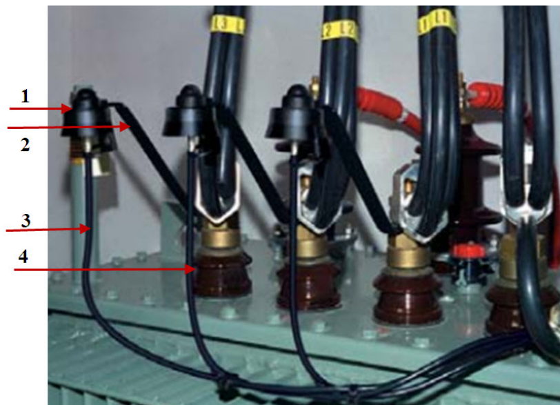
Slika K.16: Način fiksiranja odvodnika na transformatorski sud
