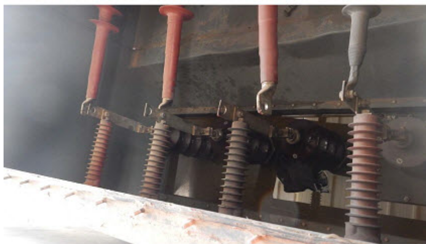
Slika G.6: Izgled havarisane priključne kutije u kojoj se nalaze prolazni izolatori 33 kV transformatora
