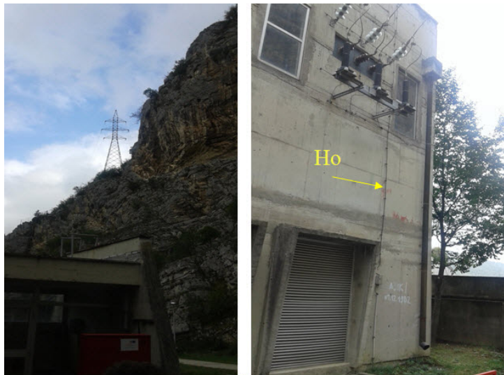
Slika D.1: Prilazni dalekovod 35 kV (levo) i priključak na zgradi sa odvodnicima prenapona (desno)
