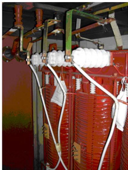
Slika B.11: 1 Slike uljnog i suvog transformatora sa postavljenim odvodnicima prenapona sa silikonskim kućištima direktno na konstrukciji
