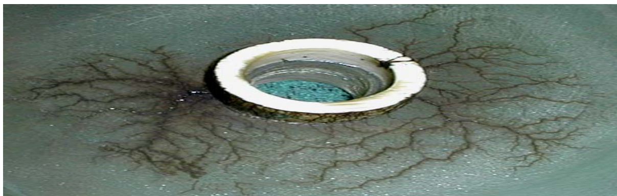
Slika 3.13: Fotografija preseka izolacije sa izraženim oštećenjem u obliku grananja
