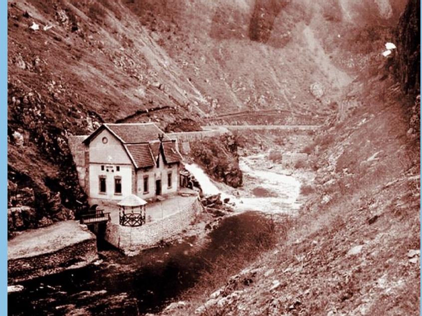
Хидроелектрана на Ђетињи, у Ужицу
