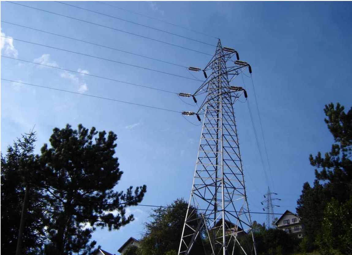
Slika 2.1 Dva paralelno vođena 110kV voda na istim stubovima sa rasporedom faznih provodnika sličnim kao u analiziranom zadatku
